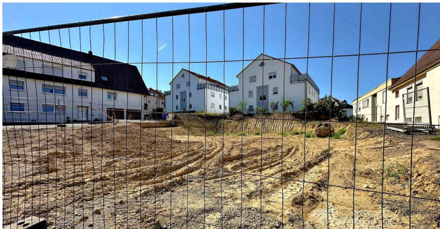
Auf dieser Fläche hinter dem Verwaltungsgebäude der GWO soll ein moderner Erweiterungsbau für die GWO entstehen. Im Anschluss wird das Bestandsgebäude saniert.
