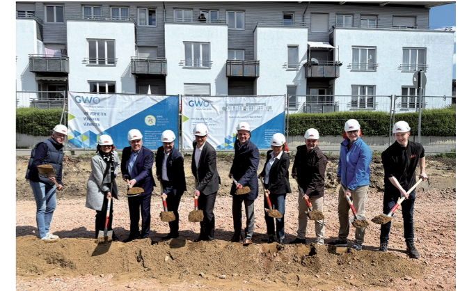
Spatenstich Brühlstraße 1 und 3 in Erbach, 20 Mietwohnungen
