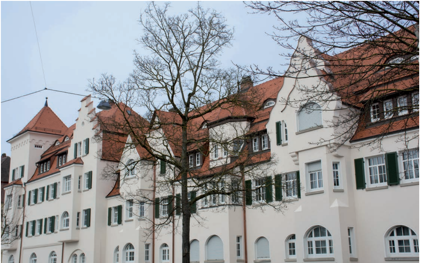
Modernisierte Mietwohnungen Wörthstraße 40-50, Ulm Auszeichnung mit der Pro-Ulma-Plakette für vorbildliches Restaurieren alter Gebäude
